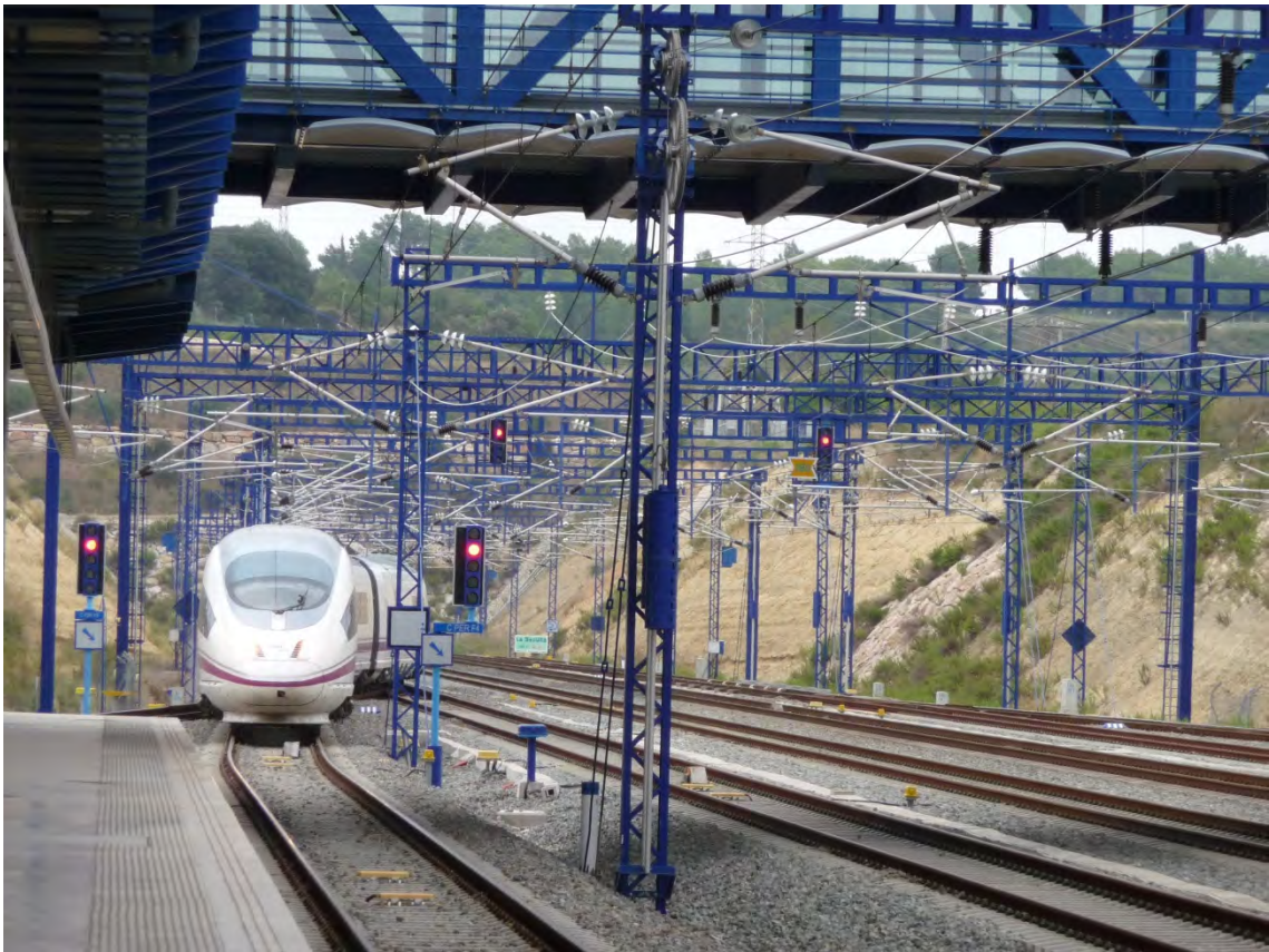
Entrada de un s103 en la estación de Camp de Tarragona (LAV Madrid-Barcelona-F. francesa)
