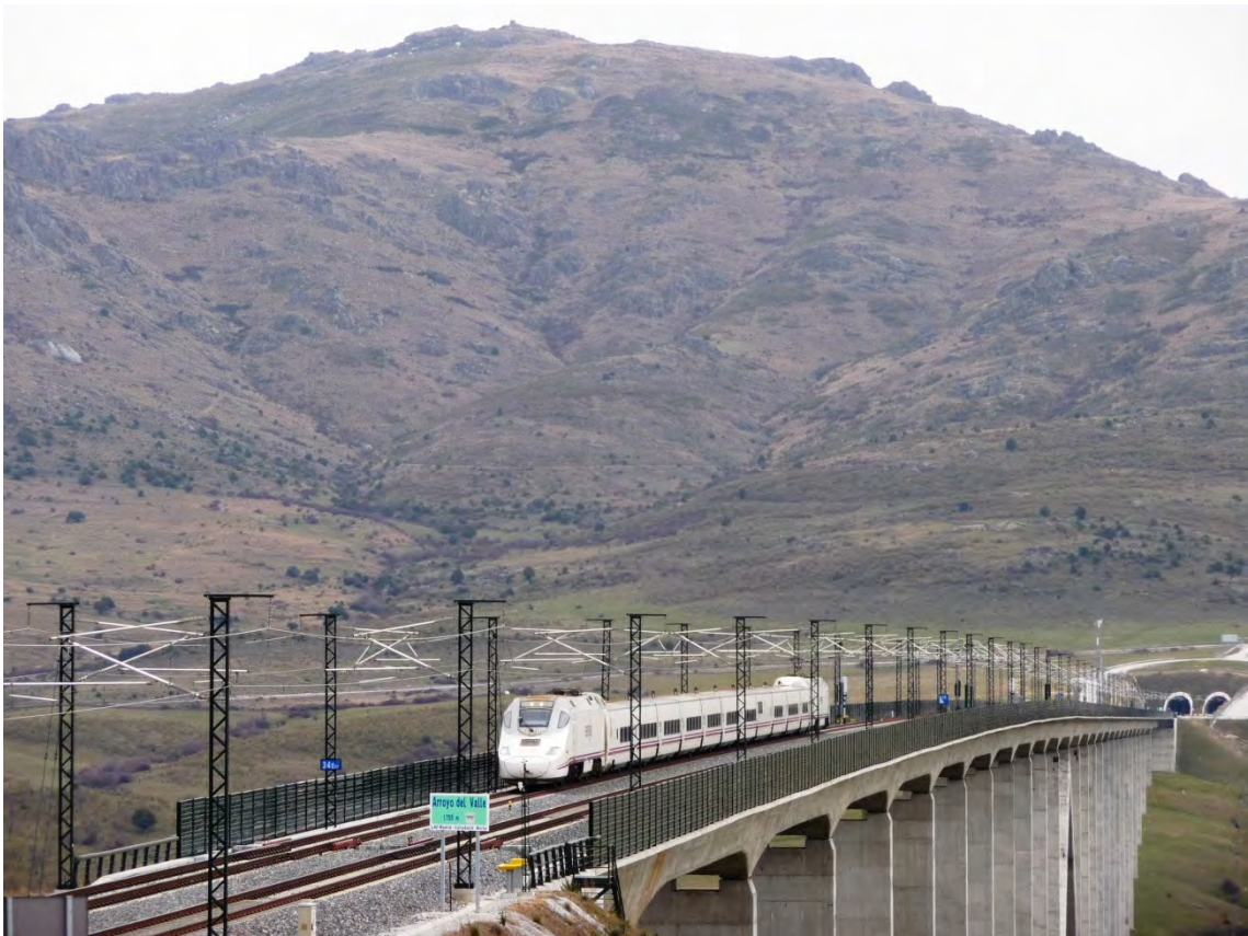
Paso de un s130 por el viaducto de Arroyo del Valle (LAV Madrid-Valladolid)
