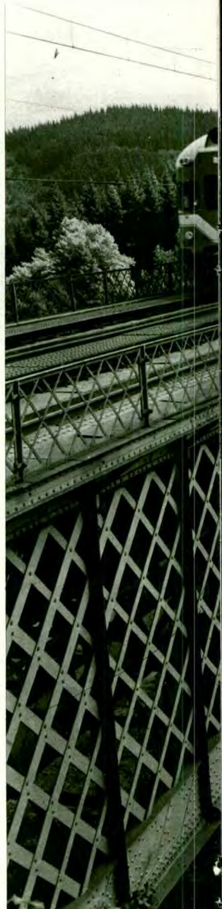
Desde 1863, fecha de su construcción, hasta la actualidad, el espectacular viaducto de Ormaiztegui, en la provincia de Guipúzcoa, ha soportado el peso de miles de trenes (890.600, a razón de 20 circulaciones diarias), desde las ligeras y pintorescas
